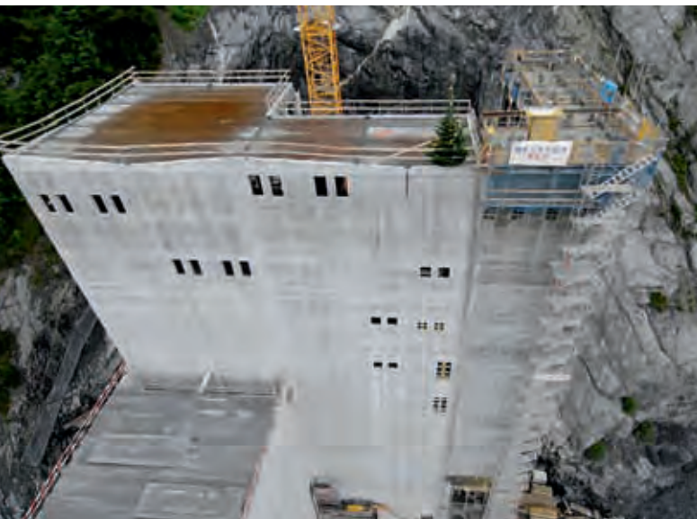
Der Turm von 56 m Höhe und einer Betonkubatur von 8'500 m 3 wurde in 17 Arbeitstagen mit Gleitschalung nonstop hochgeführt Foto: zVg
