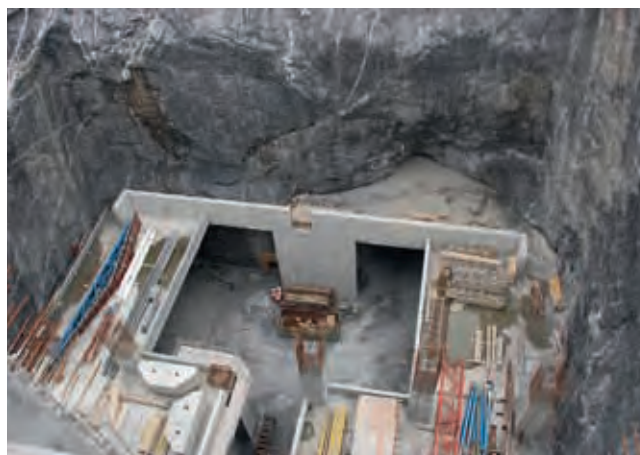
Die Gewinnung des hochprozentigen Kalksteins geschieht von der Rückseite des Turms aus durch einen Zugangsstollen Untertage im Kammer-Pfeiler-Abbauverfahren
