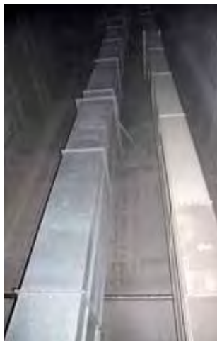
Mit 60 m Höhe für die Schweiz aussergewöhnlich ist das Becherwerk für die Zuschlagstoff-Förderung
