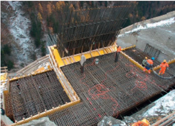
Bei winterlichen Verhältnissen fand die Kämpfer-Betonierung auf Seite Valens Ende November statt und erforderte für die 800 m 3 Beton rund 25 Stunden
