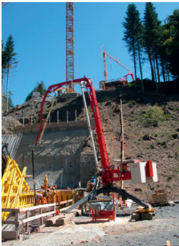
Beim Betoniervorgang für den Kämpfer Pfäfers waren eine 60 t schwere Betonpumpe M 58 von Putzmeister, ein 130 m langes Verlängerungsrohr und ein Betonverteilmast eingesetzt. Fotos: zVg
