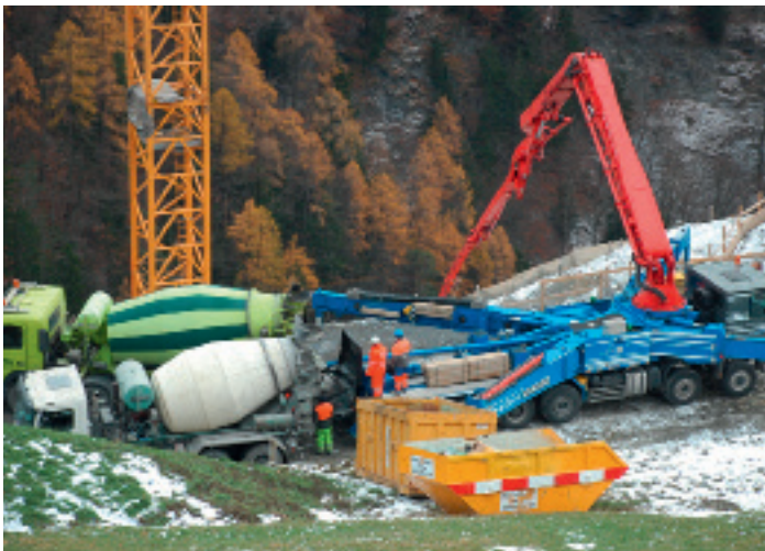
Für das 475 m lange und 260 m Spannweite aufweisende Brückenprojekt über die 200 m tiefe Schlucht waren in einer ersten Bauphase die beidseitigen Widerlager und die Kämpferfundamente mit einer Kubatur von 2'000 m 3 und 800 m 3 zu betonieren
